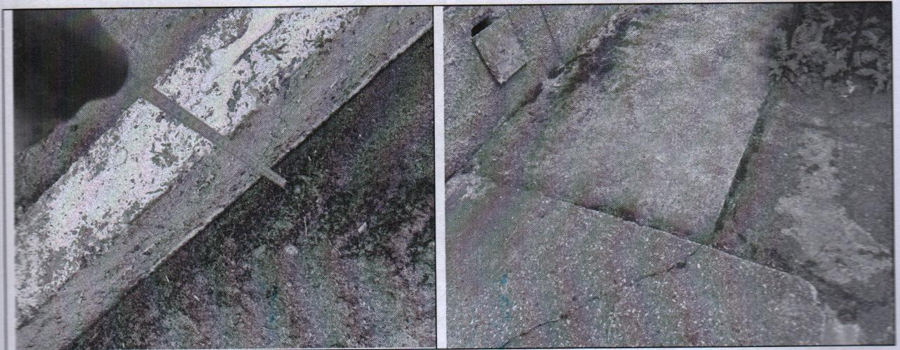
**Фото №2.** На фото ліворуч: перепад у рівнях (висота бордюру) дорожнього покриття та конструкції вимощення – близько 180мм. Перепад у рівнях між конструкцією бетонної площадки входу та конструкцією вимощення – близько 80мм.
