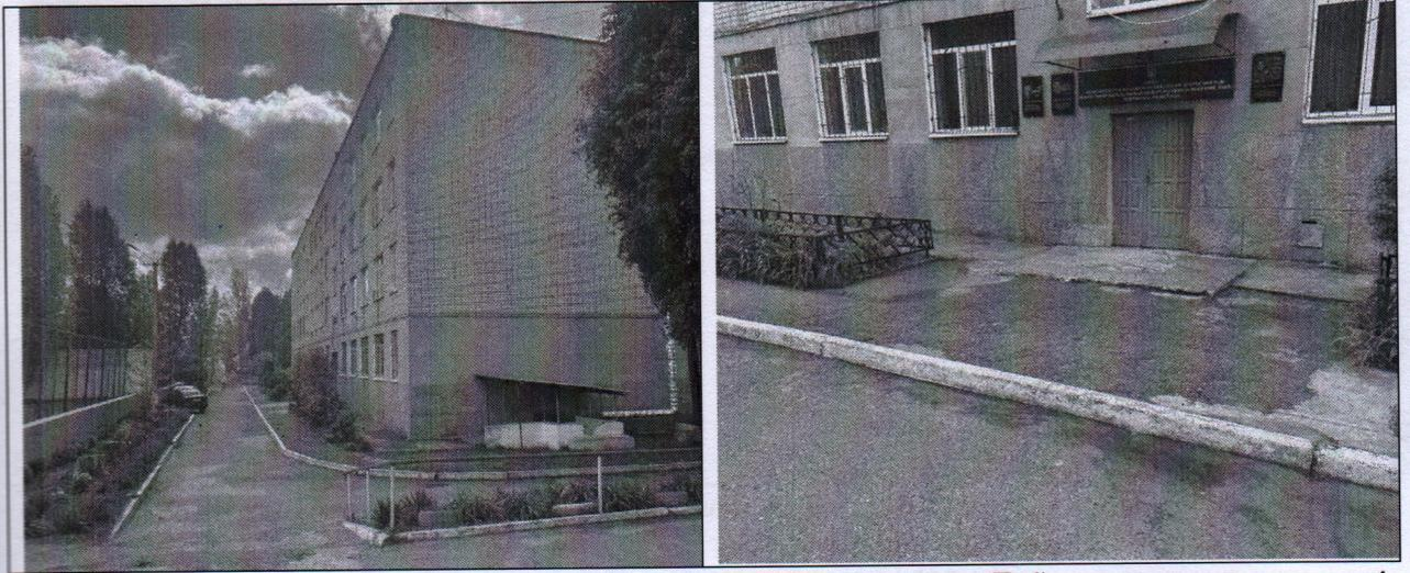
**Фото №1.** 4-поверхова будівля навчального корпусу ліцею (літ. Б-4) – прямокутна в плані цегляна споруда з підвалом, яка розташована на окремій огороженій земельній ділянці. На внутрішньому фасаді будівлі улаштовані 2 (два) відкриті танки входів з площадками та металевими навісами. Бетонна площадка перед входними дверима розташована на рівні +80мм від рівня з конструкції вимощення з асфальту. Поточний технічний стан будівлі у цілому – задовільний (2-га категорія технічних станів).
