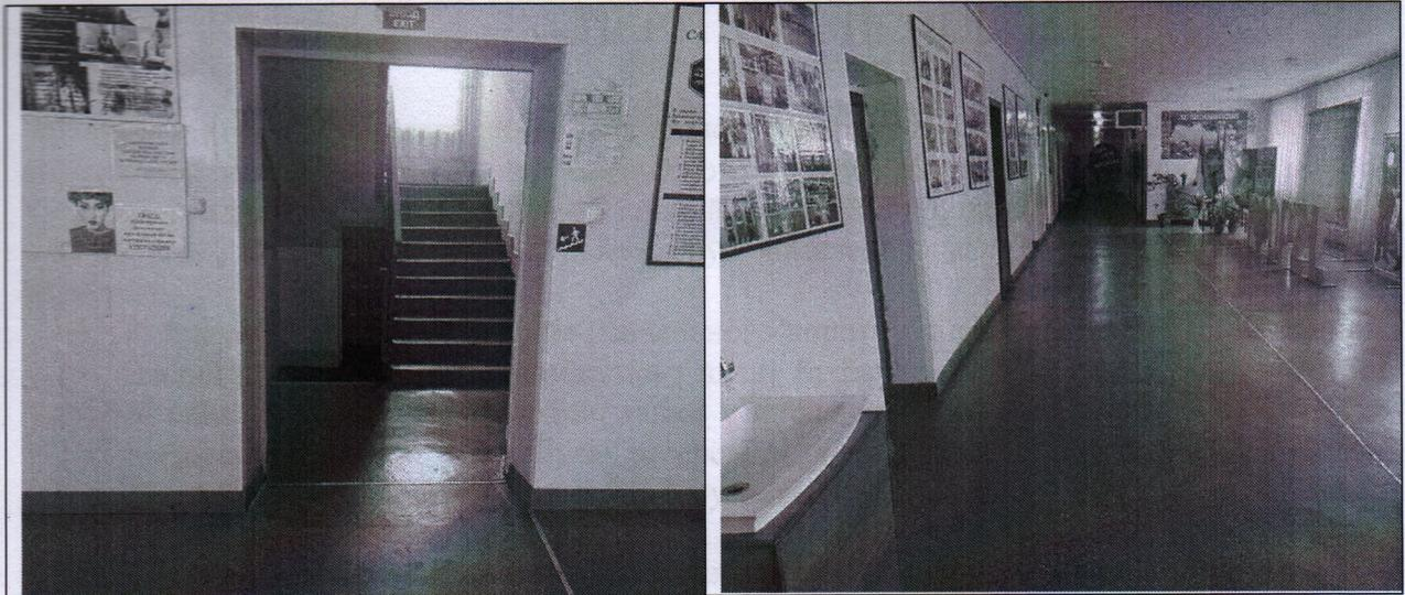
*Фото №5. Ширина дверних отворів (проходів) між приміщеннями №119 (сходи з площадкою) та 101 (коридор) Об'єкту – не менше 1200 мм, ширина коридорів – значно більше за 1500 мм. Конструкція підлоги з лінолеуму без вертикальних перешок, двері у кабінети 1-го поверху виконані без порогів.*
