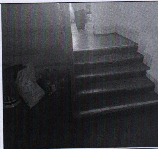
Фото №3. Вхідні двох стулкові двері відкритого танку одного зі входів розташовані на одному рівні з рівнем бетонної площадки танку, мають достатні габарити отвору (1200мм), підлога внутрішнього тамбура (прим. №118, №119) розташована практично на рівні площадки.
