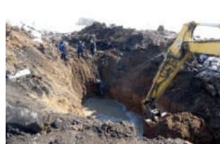
Іл. 34.11. Викопування водовідвідної канави
