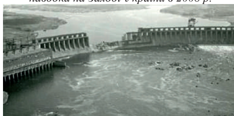
Іл. 33.7. Зруйнована вибухом гребля Дніпрогесу в 1941 р.
